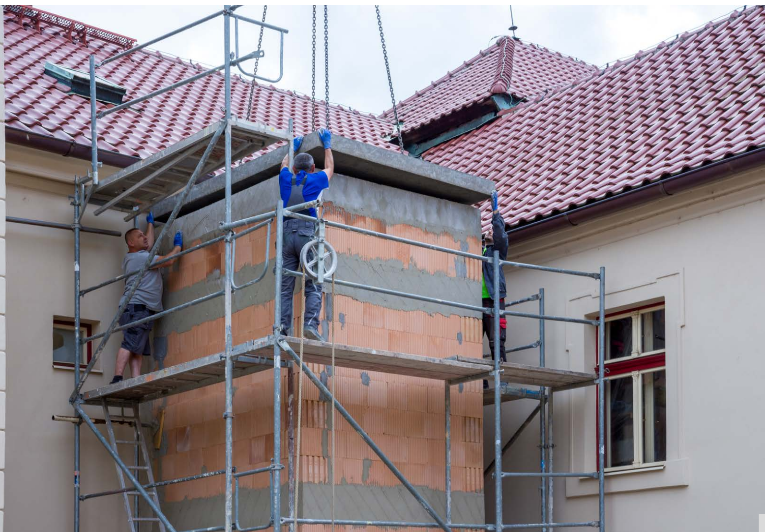
Položení panelu, který zastřešuje výtahovou šachtu, vyžadovalo spoustu přesnosti i síly.
