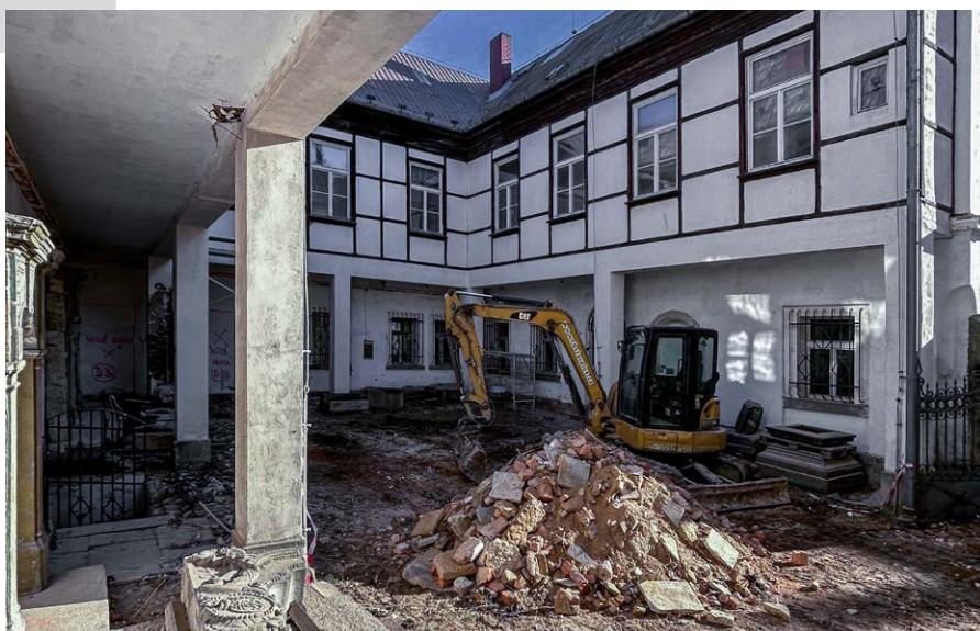
Nádvoří získá novou podlahu a dokonce skleněnou střechu. Vznikne tady víceúčelový kulturní sál.
